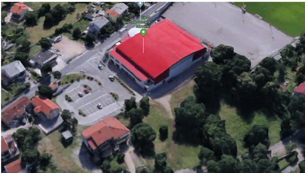
Izgled lokacije 3, fotografija iz zraka
