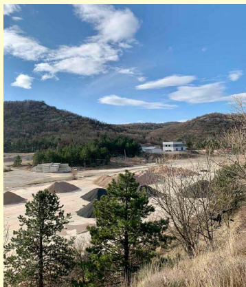
IZGRADNJA CESTE U RADNOJ ZONI SOBOLI
