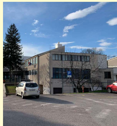
OBNOVA FASADE NA OŠ ČAVLE
