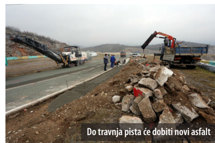
Povijesni trenutak: 4. prosinac 2017. - početak radova
