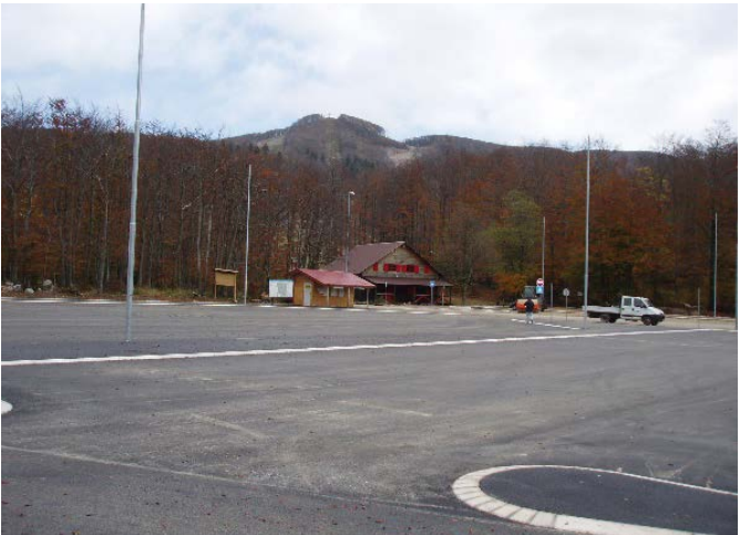
Parkiralište Platak za vrijeme i nakon radova
