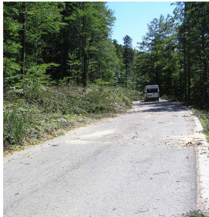
ŽC 5030 prije rekonstrukcije
