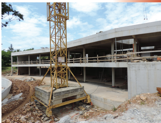
Radovi u tijeku
