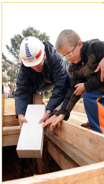
Polaganje kamena temeljca
