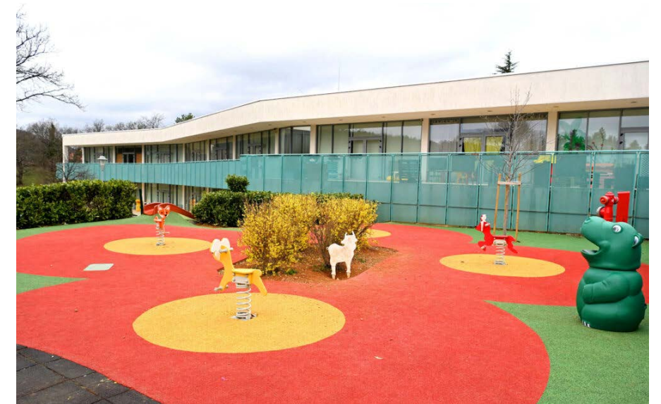
Obnovljeno igralište Dječjeg vrtića Čavlić
