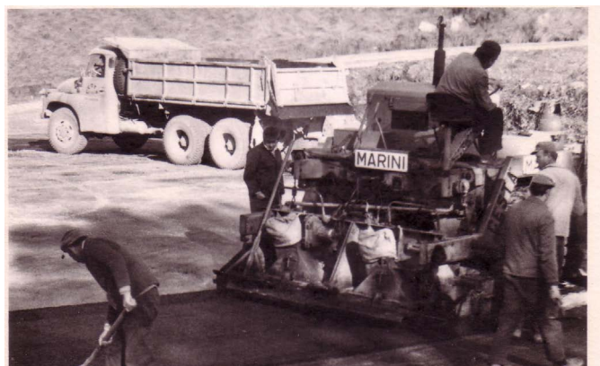
Izgradnja šk. igrališta Jama
