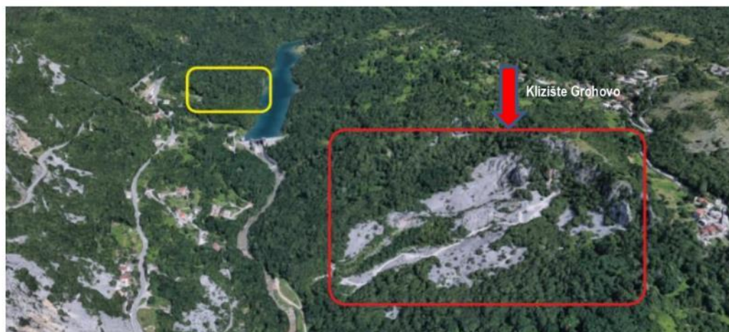
Slika 3. Klizište Grohovo (crvena oznaka)
